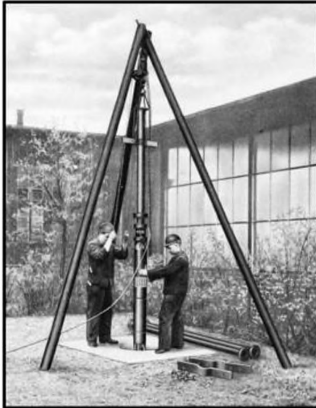
شکل ۱۷- روش نصب الکتروپمپ شناور
